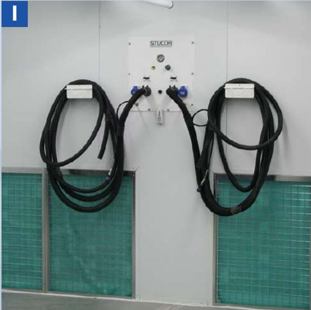
**EL PANEL MULTIFUNCION ES UN PRODUCTO UTILIZADO COMO UNA CONEXION ENTRE LA UNIDAD DE SUCCION Y EL AREA DE OPERACION. ES POSIBLE CONSTRUIRLO ENTRE LAS PAREDES DE LAS AREAS DE PREPARACION (1) O USARLO CON INSTALACION LIBRE (2).**
