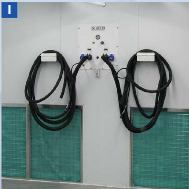
IL PANNELLO MULTIFUNZIONE È UN PRODOTTO UTILIZZATO COME COLLEGAMENTO TRA CENTRALE ASPIRANTE ED AREA OPERATIVA, È POSSIBILE INCASSARLO TRA LE PARETI DELLE ZONE DI PREPARAZIONE (1) OPPURE UTILIZZARLO A LIBERA INSTALLAZIONE (2).
